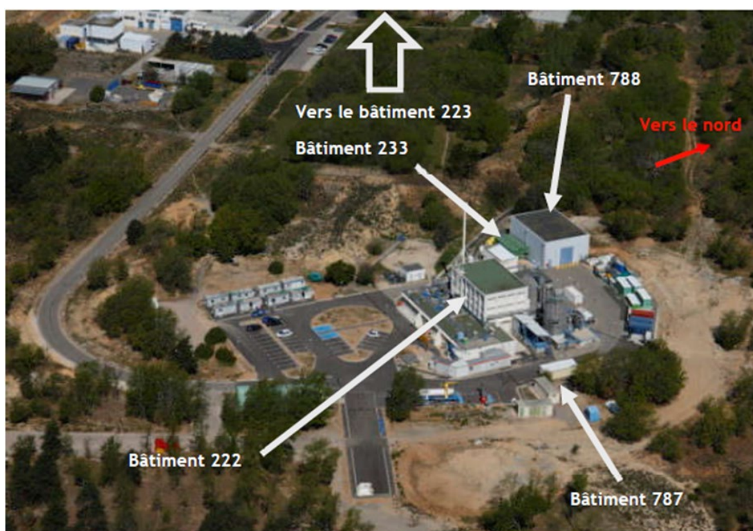
Figure 2 : Bâtiments de l'INB n°24
